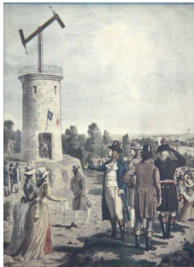
Figura 10. Ilustración que recrea una torre del sistema telegráfico óptico desarrollado por Claude Chappe a finales del siglo XVIII.
