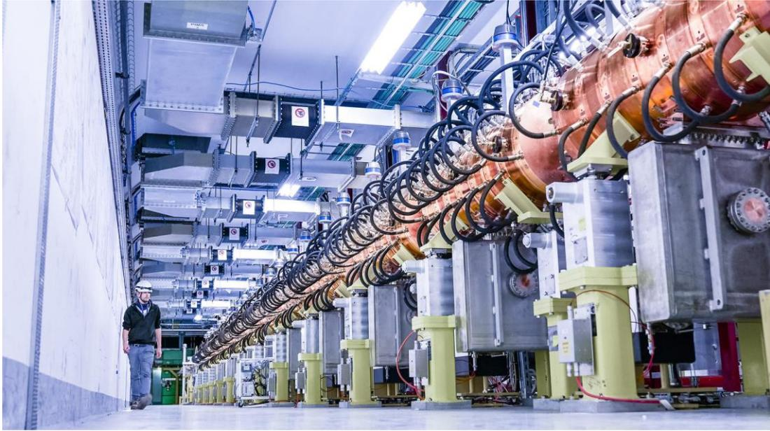
Figura 26: Fotografía del LINAC 4, el nuevo inyector de 86 m. situado 12 m. bajo tierra que acelera iones de H- hasta 160 MeV antes de pasar las partículas al PS.
