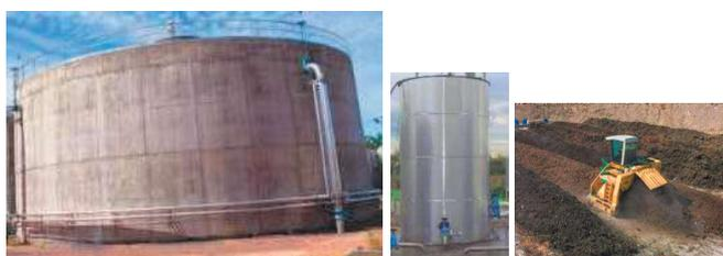
Figura 41. Digestor anaerobio. Digestor aerobio y planta de compostaje
