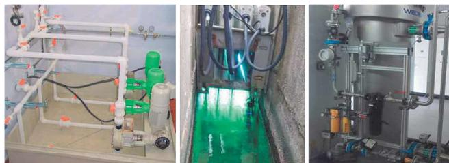
Figura 11. Cloración. Luz Ultravioleta. Ozonización
