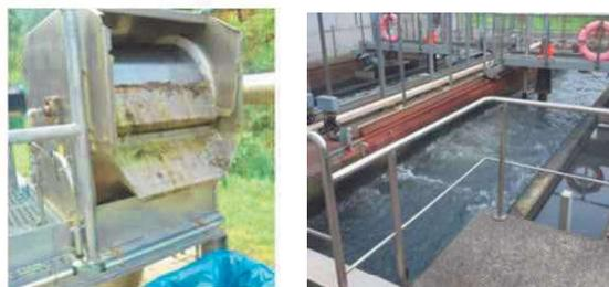
Figura 15. Cribado y desarenado
