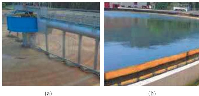
Figura 34. Sedimentador vacío (a) y lleno mostrando el vertedero (b)
