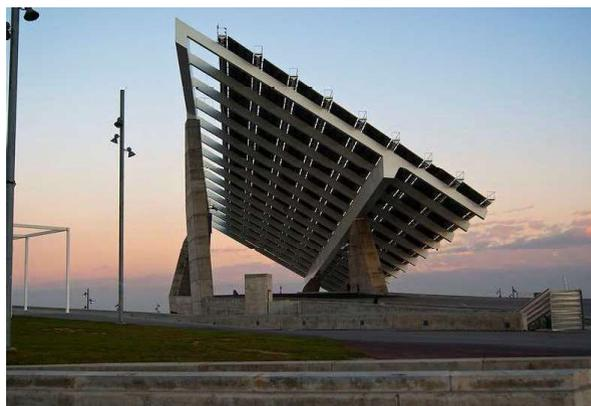
Figura 15. Fotografía de la llamada "pérgola fotovoltaica del Fórum", en Barcelona. Ocupa unos 4.000 metros cuadrados y consta de casi 3.000 paneles solares.
