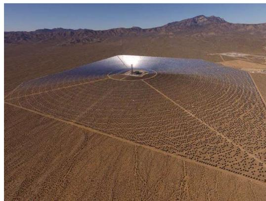
Figura 17. Fotografía de la central termosolar de Ivanpah, en el desierto de Mojave, en California. Consta de 173.500 heliostatos de 2 espejos, que apuntan a 3 torres centrales de 139,3 metros de altura. La máxima potencia producida es 392 megavatios.
