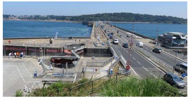
Figura 20. Un ejemplo de energía "geoprimitiva" es la energía mecánica obtenida como consecuencia de las mareas. Esta energía mecánica puede ser transformada en eléctrica en centrales como la mostrada en esta figura, la primera en su género, situada en el estuario del río Rance, entre Dinard y Saint-Malo, en Francia. Opera desde el año 1966 y posee 24 turbinas acopladas a generadores de 10 MW.
